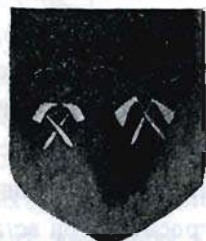
Кельнскихъ масо- новъ (съ печати 1396 г.). Maçons de Cologne.
